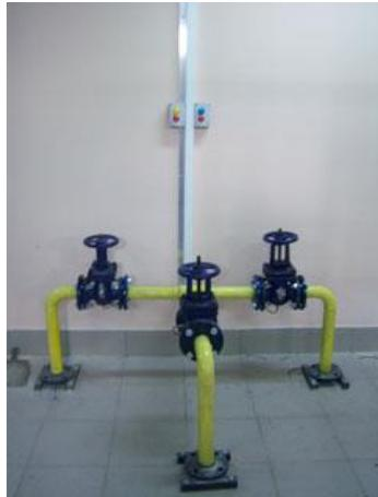
**Тренажер «Задвижка»** предназначен для подготовки всех категорий специалистов, работа которых связана с ведением аварийно-восстановительных работ на предприятиях нефтехимического, химического и газового комплекса, в металлургической промышленности и коммунальных службах, а также для подготовки специалистов подразделений МЧС России.
